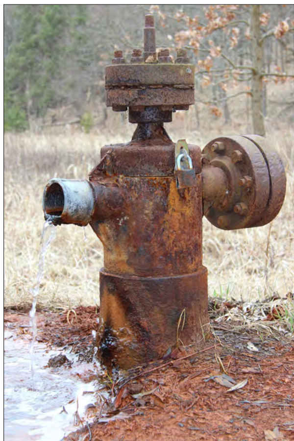
Fot. 3.3. Niezagospodarowane ujęcie wód termalnych Frombork IG-1 (fot. J. Sokołowski)
