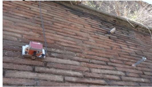
D pochyłomierz precyzyjny w otoczeniu geodezyjnych punktów pomiarowych (fot. A. Borecka)
