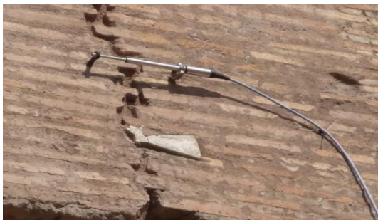
E szczelinomierz precyzyjny(fot. A.Borecka)
